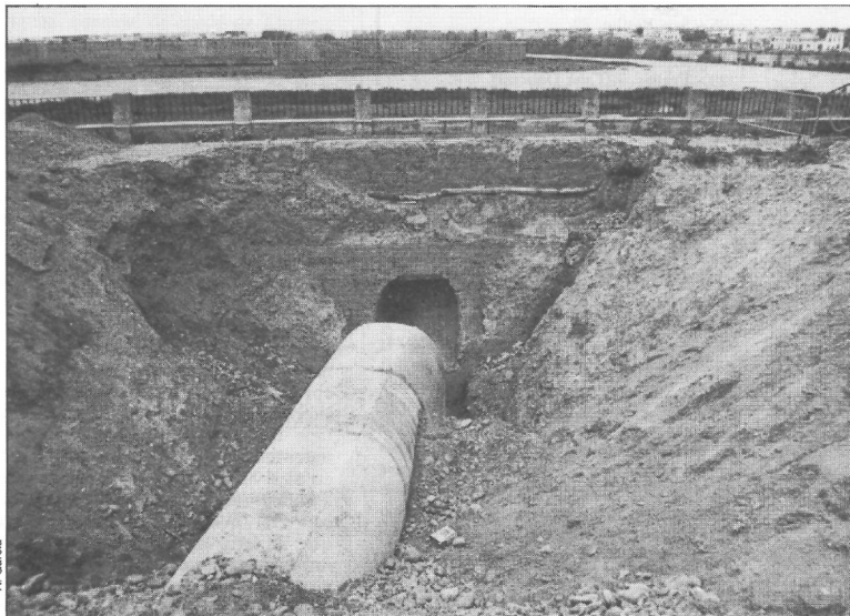
El plan de inversiones de Emacsa, contempla obras de abastecimiento en varias barriadas. En la foto la red de colectores, en obras.
